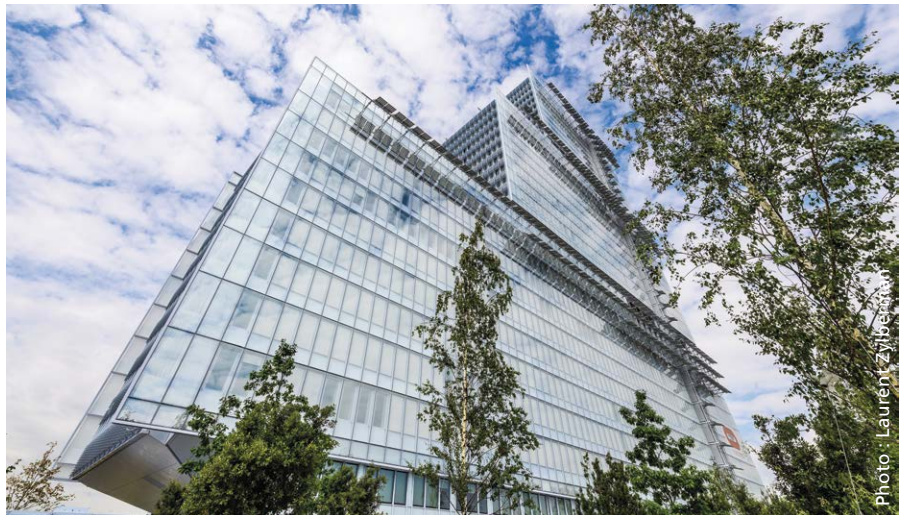
▲ Tribunal de grande instance de Paris ; architecte : Renzo Piano Building Workshop. Verre Saint-Gobain, peau extérieure SGG Cool-Lite ST Bright Silver
