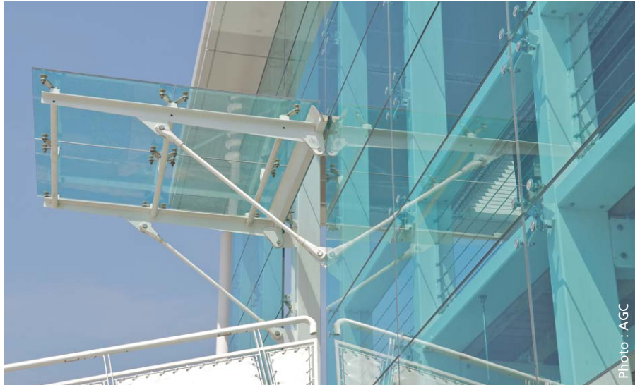
▲ Musée maritime de La Rochelle : 2 500 m 2 de façade en VEA Structura Vision feuilleté trempé HST AGC Glass Europe (coupe et pare-flammes)
