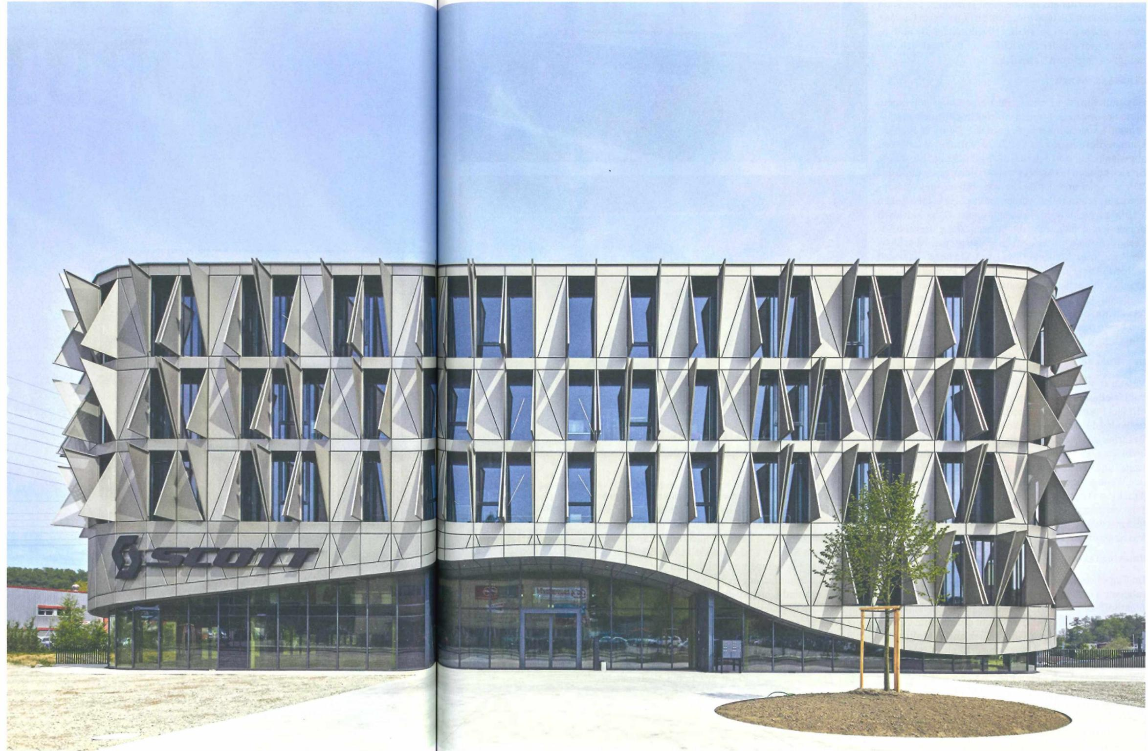
rüst des Neubaus aus Betonsäulen verhüllen. Selbst im geschlossenen Zustand – wenn die triangulierte Fassade ihre Stacheln nicht aufstellt – gewährleistet die Mikrolochperforierung der Dreiecksflügel die Ausleuchtung der Innenräume mit Tageslicht.
